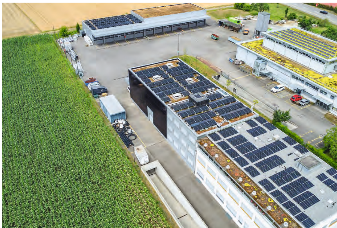
PV-Anlage in Betrieb
