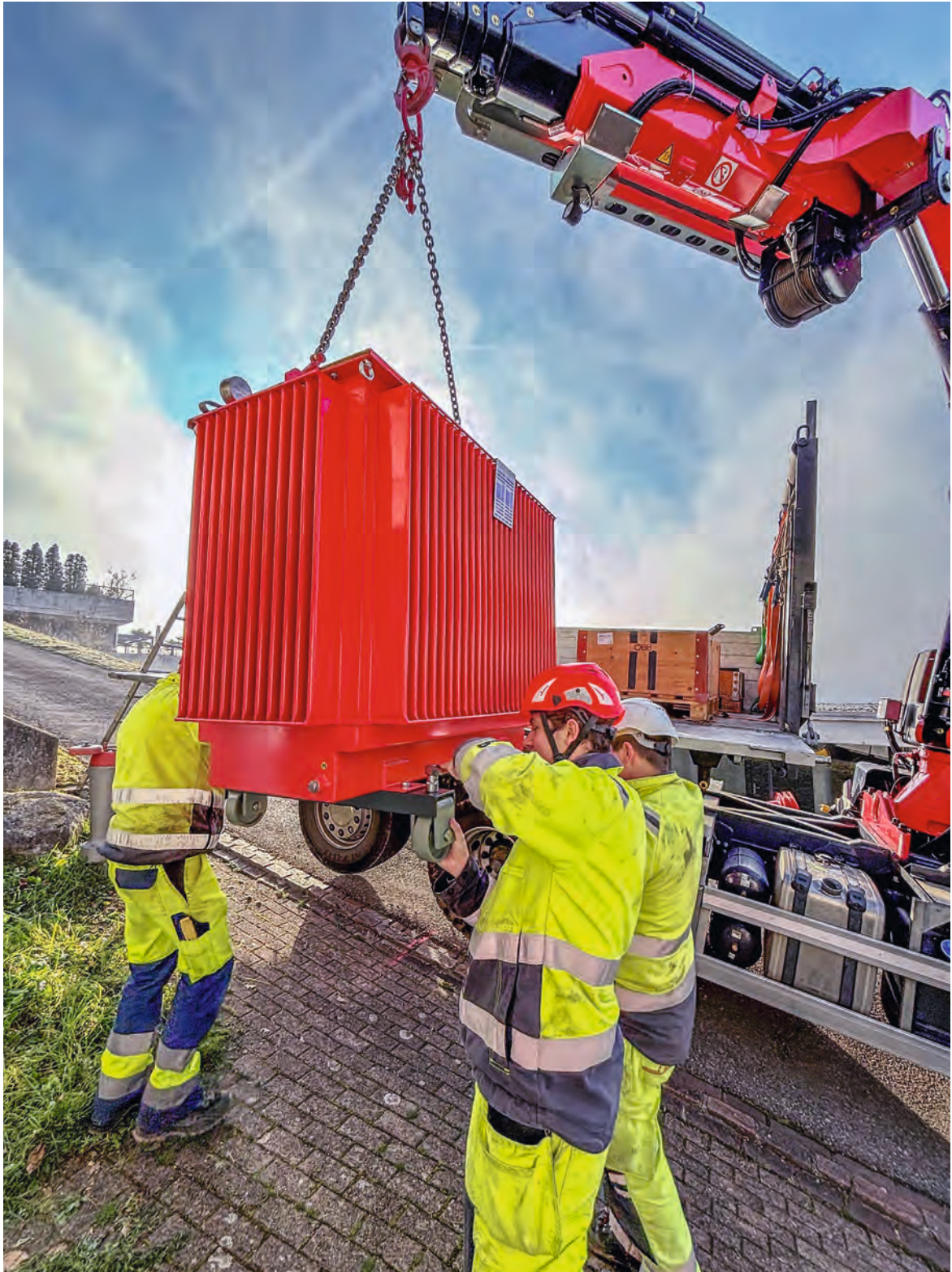
Abladen des neuen Transformators
